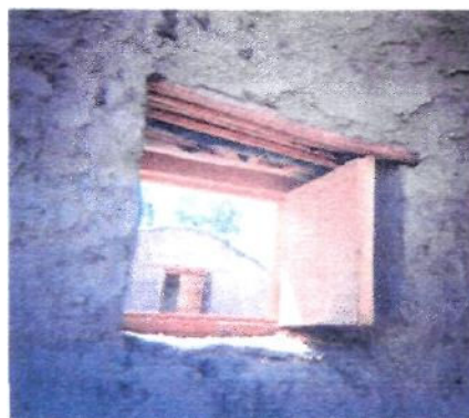
Фото 27 и 28 - Установленное боковое вентиляционное отверстие, затянутое проволочной сеткой
