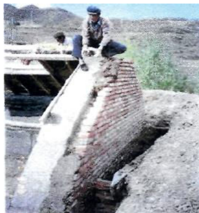
Фото 17 - Строительство двойной стены из сырцового кирпича в Ладахе.
