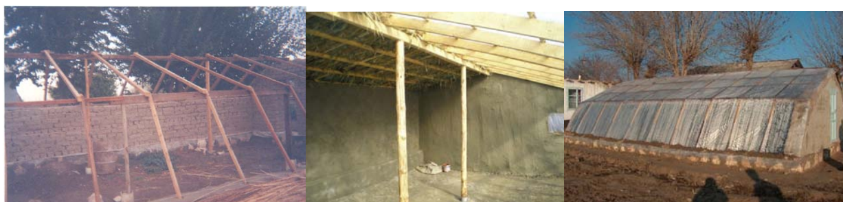
Фото 5, 6, 7 – конструкция солнечных теплиц
