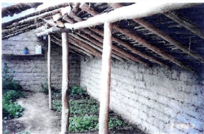
Фото 33 - Одна горизонтальная балка и несколько поперечных балок в Спити.
