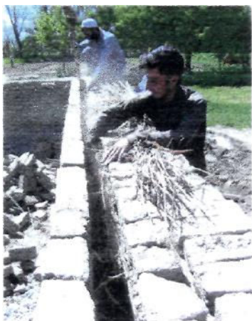
Фото 19 - Двойная стена и теплоизоляционной наполнитель.
