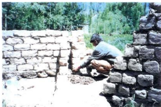
Фото 17 - Строительство двойной стены из сырцового кирпича в Ладахе.
