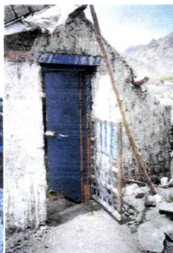
Фото 23 - Кладка вокруг дверного проема в несущей стене. Фото 24 - Вторая створка обтянутая металлическими полосами.
