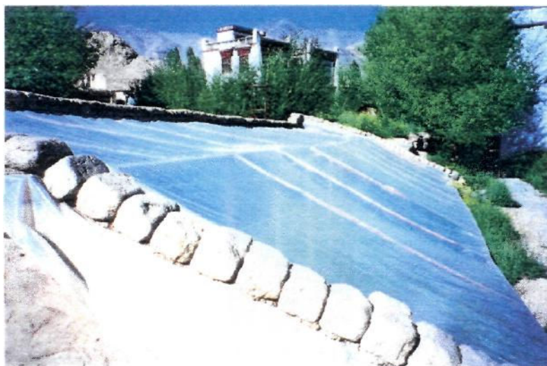
Фото 42 - Крепление полиэтилена с помощью кирпичей поверх слоя глины.
