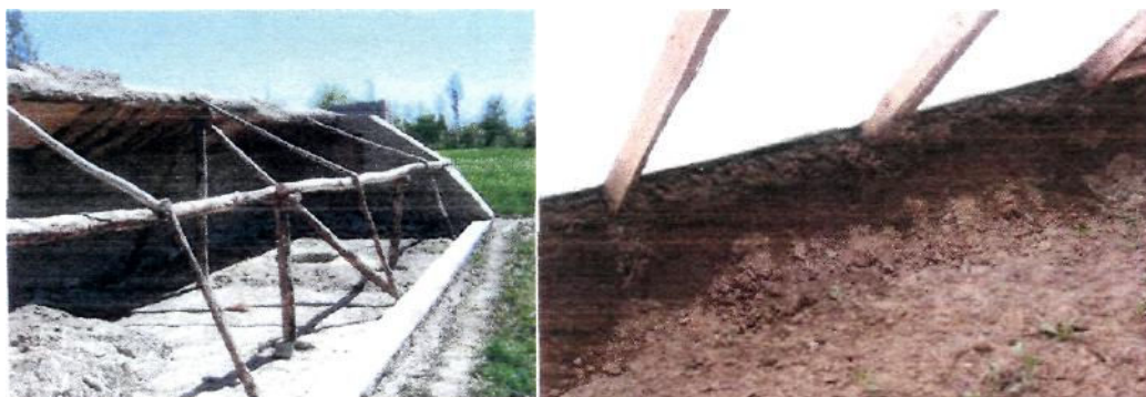
Фото 40 - Деревянная конструкция для поддержки полиэтилена (Ловгар, Афганистан) Фото 41 - Растрескивание земли в результате размещения балок непосредственно на грунте
