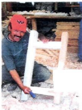
Фото 25 - Изготовление рамы для вентиляционного отверстия
