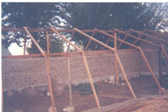
Схема 25 - Строительство стен, установка балок
