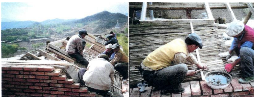
Фото 38 и 39 - Конструкция крыши, сделанной из древесины и бамбука в Кингае
