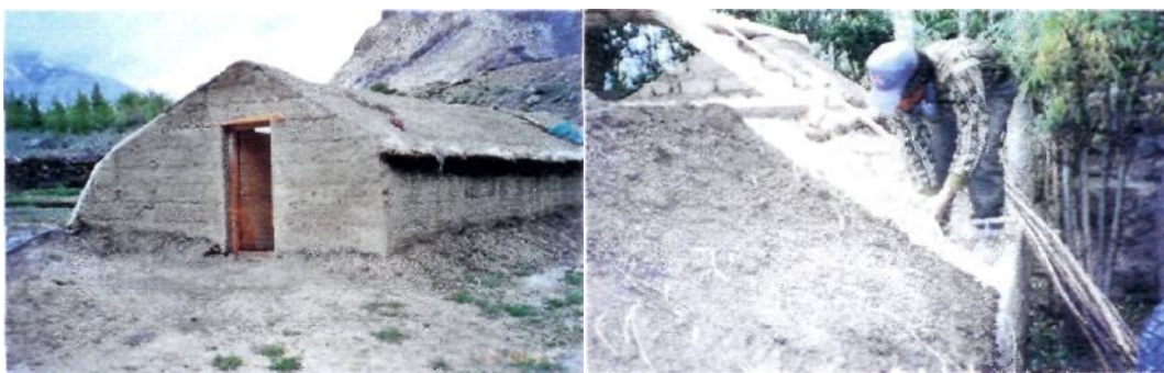
Фото 35 - Небольшой свес крыши с задней стороны теплицы в Спити. Фото 36 - Покрытие крыши картоном, соломой и глиной
