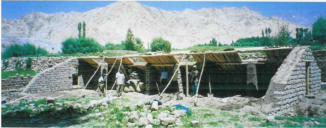
Фото 8 - Теплица в процессе строительства (вид на двойные стены и конструкцию крыши)
