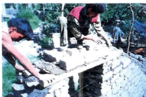
Фото 23 - Кладка вокруг дверного проема в несущей стене. Фото 24 - Вторая створка обтянутая металлическими полосами.
