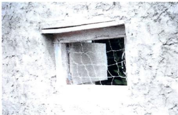
Фото 27 и 28 - Установленное боковое вентиляционное отверстие, затянутое проволочной сеткой
