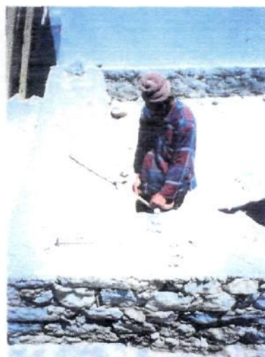
Фото 11 - Определение направления на юг с использованием веревки с отвесом
