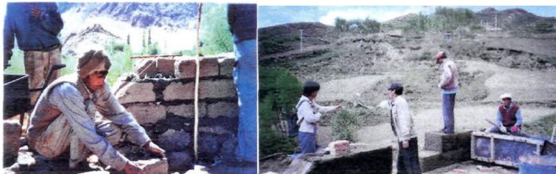
Фото 15 и 16 - Определение формы будущей стены при помощи веревки (в Кингае и Ладахе)
