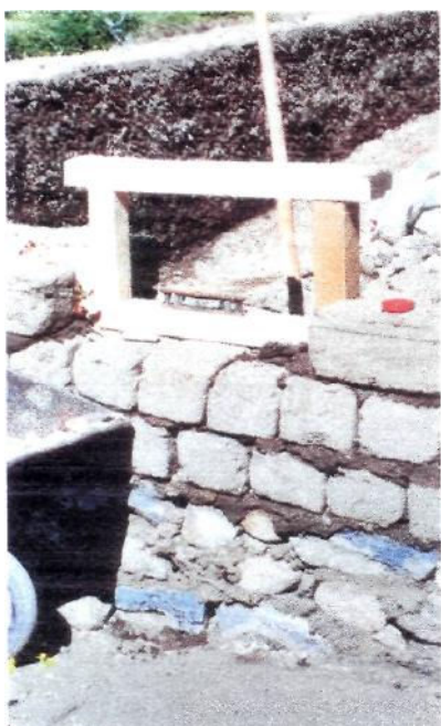
Фото 26 - Расположение рамы на стене.
